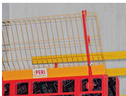
U bednění stěn je možné použití ochranné mříže i jako zábradlí na opačné straně.
