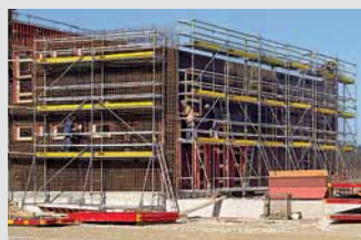
Pracovní lešení na staveništích
