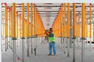
Stropní bednění
