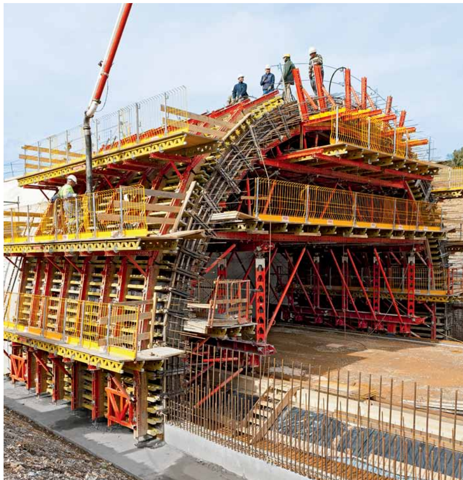
PROKIT EP 110 vytváří ochranu všech volných okrajů pracovních plošin tohoto tunelového bednění.
